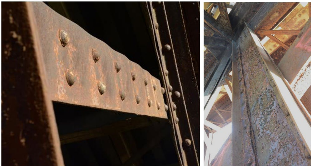
Fig.1 Esempi di corrosione in fessura tipo "pack rust" riscontrati su elementi sottili del ponte San Michele di Paderno d'Adda.
